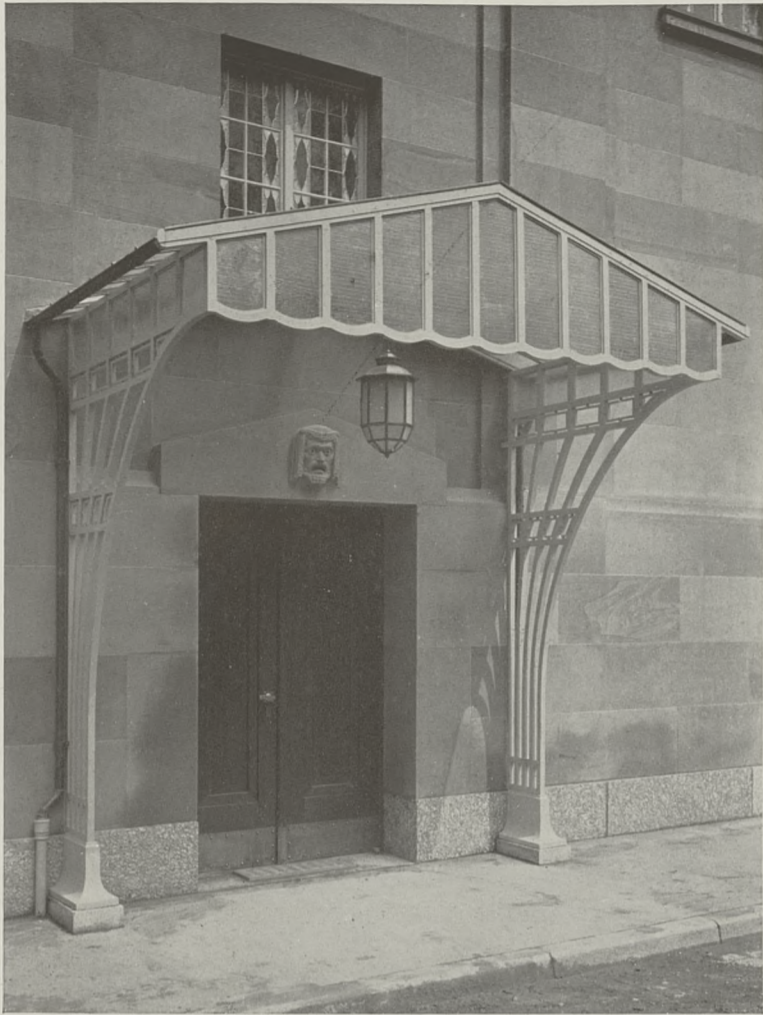
SEITLICHER AUSGANG DER I. RANGTREPPE, KLEINES HAUS
