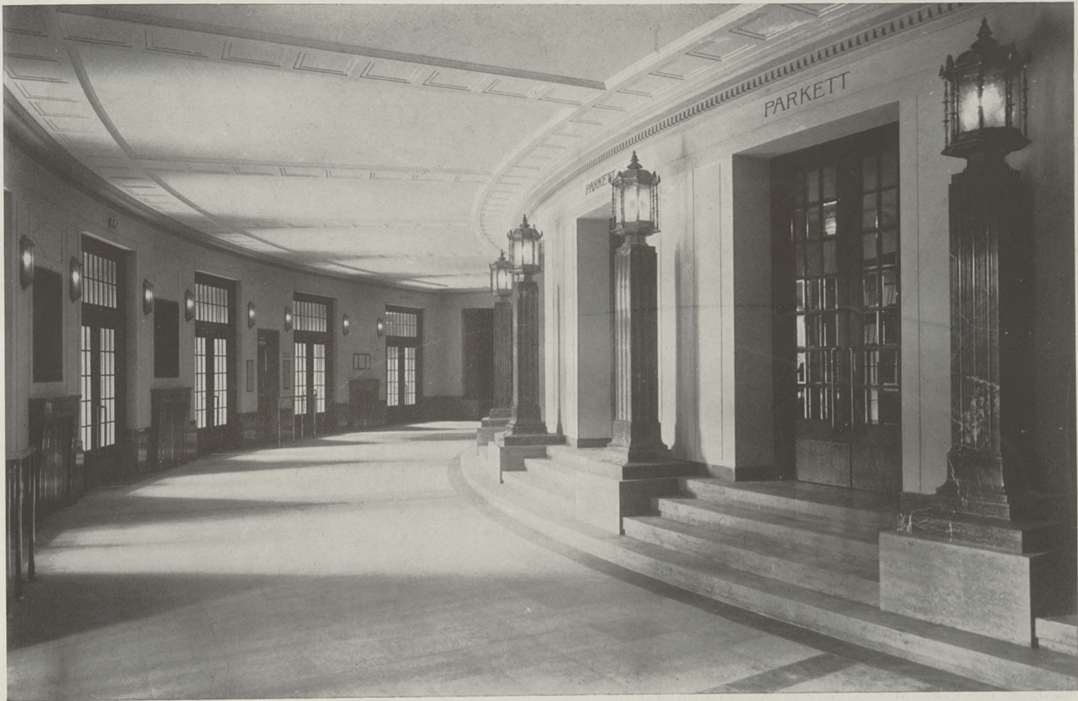
KASSENFLUR IM GROSSEN HAUS
