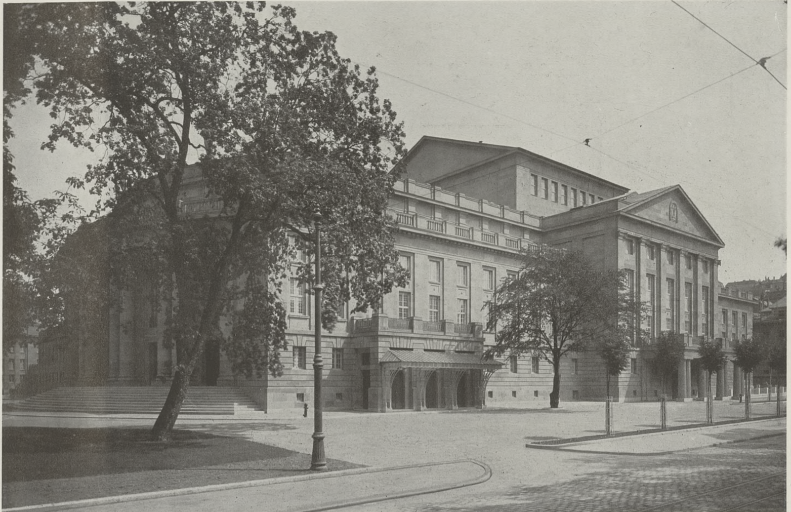
GROSSES HAUS. FRONT AN DER SCHLOSSGARTENSTRASSE
