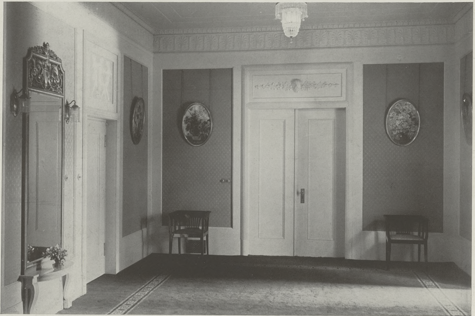
FOYER DER MAJESTÄTEN IM GROSSEN HAUS
