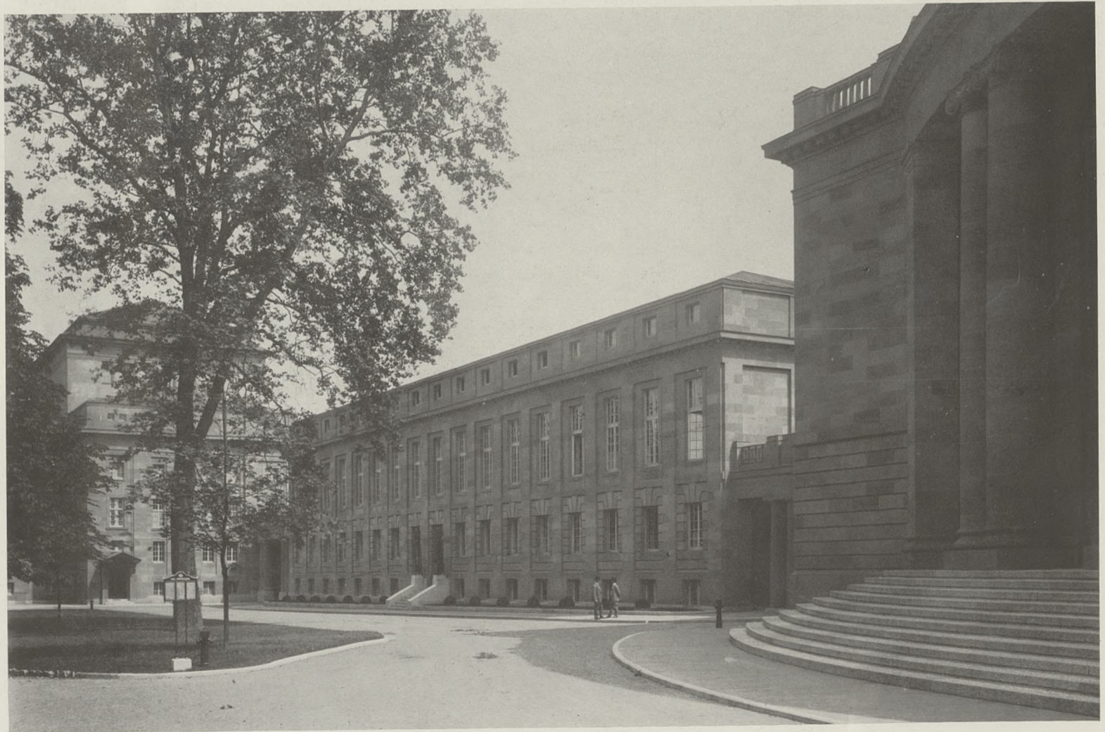
VERWALTUNGSGEBÄUDE MIT BLICK NACH DEM KLEINEN HAUS
