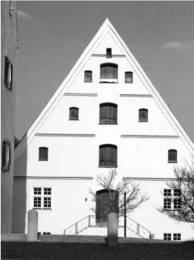
Abb. 27b: Bräuhaus nach der Instandsetzung, Westansicht. Photo 1999
