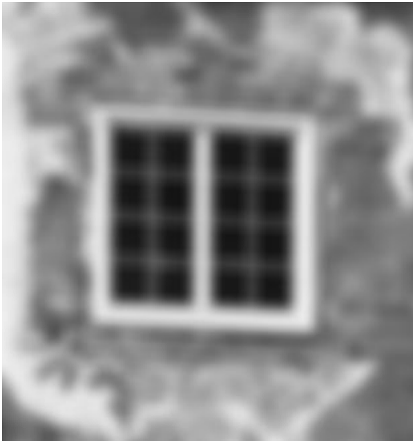
Abb. 19: Pächterwohngebäude. Neue Fensterformen und dekorative, um 1500 gefertigte Bemalung der früheren Gewände. Photo 1970
