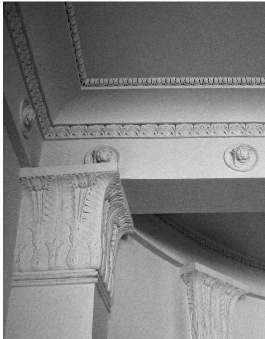
Abb. 76: Schloss Ludwigsburg, Gardesaal (Raum 145). 2. Obergeschoss. Südseite mit Stuckornamenten, 2004
