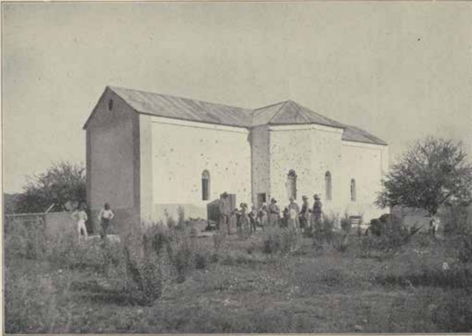
Kirche in Oshandja, zerstört durch die Belagerung von der Schanze aus.
