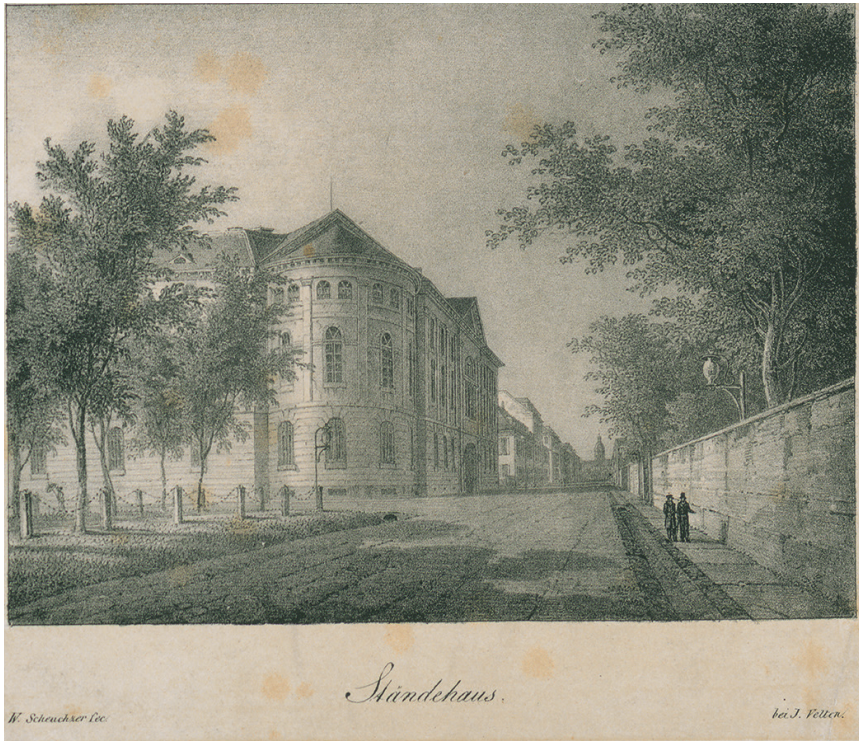
Tafel 10: Das Ständehaus in der Karlsruher Ritterstraße, an deren nördlichen Ende das großherzogliche Residenzschloss zu erkennen ist, nach 1826.
