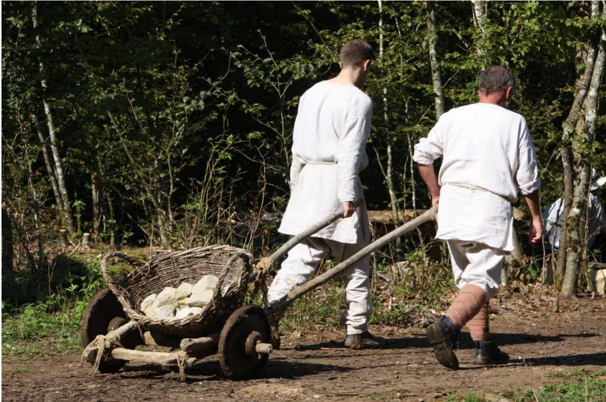
Transport von Baumaterial im Campus Galli (Bild: Markus Fiederer)
