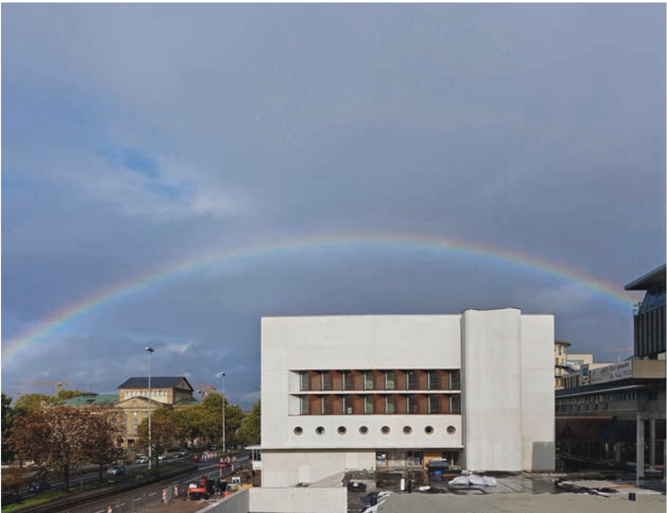
Abb. 8: Württembergische Landesbibliothek – Erweiterungsbau (2019)
