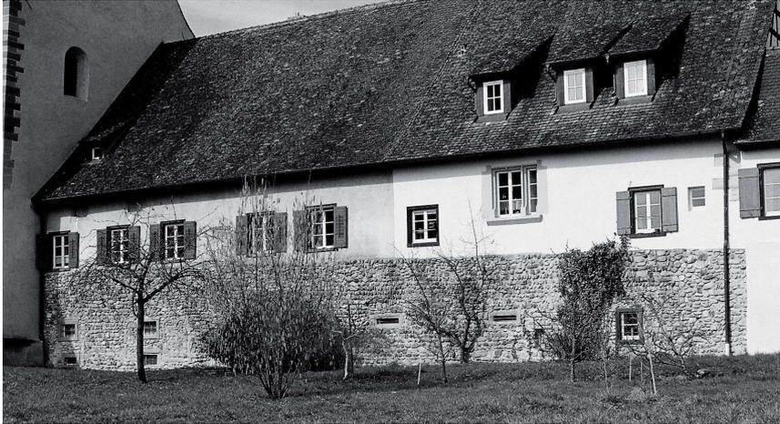
*Abb. 3: Reichenau, alter Konventswestflügel (Ostseite): Mauerreste des 9. Jahrhunderts, spätmittelalterliche Überbauung (Dormitorium), umgebaut 1595.*
