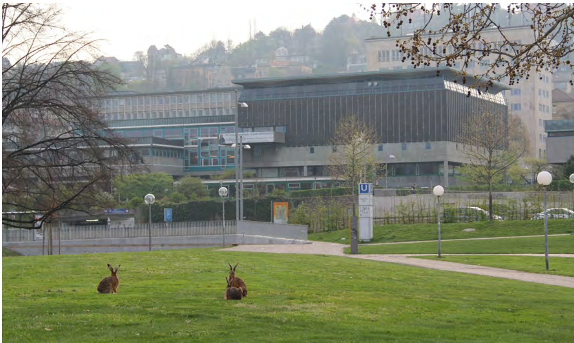
Das heutige Bibliotheksgebäude
