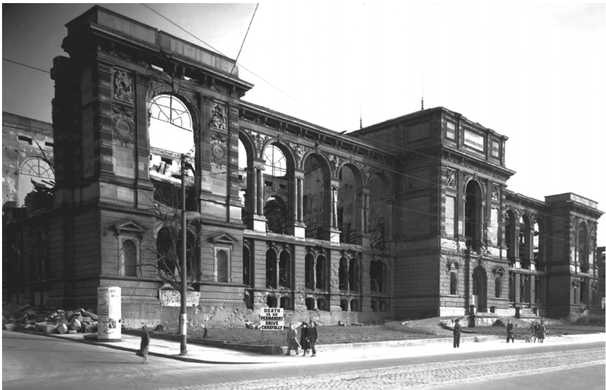
Das zerstörte Bibliotheksgebäude nach dem Luftangriff im September 1944
